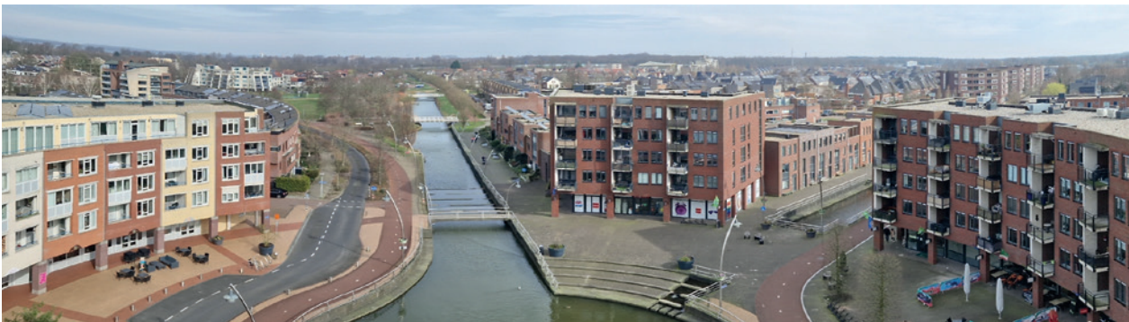
Overzicht van de wijk rondom het winkelcentrum richting Operettedreef
